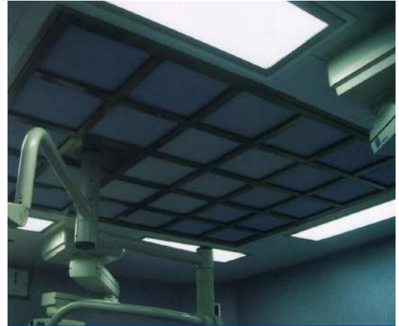
Fig. 5 Esempio di Plafone filtrante dotato di Filtro Hepa
